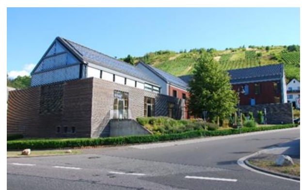
Abb. 6: Verwaltungsgebäude, Verbandsgemeinde Ruwer Foto: Verbandsgemeinde Ruwer
